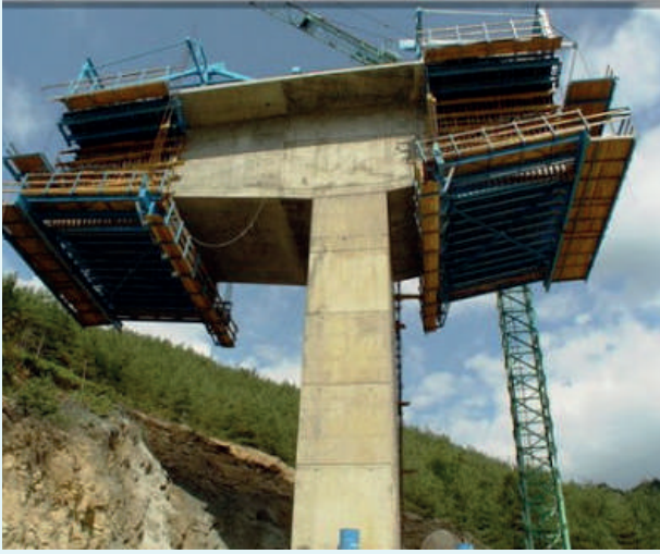
SÜMERKANT İNŞAAT VIYADÜK İNŞAATI
